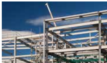
Konstruktions- und Stahlbau
